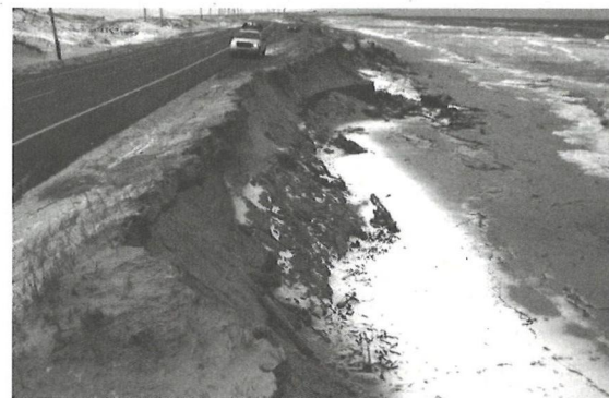
Infrastructure routière menacée sur la dune du Nord - Automne 2007 - Source : MTQ
