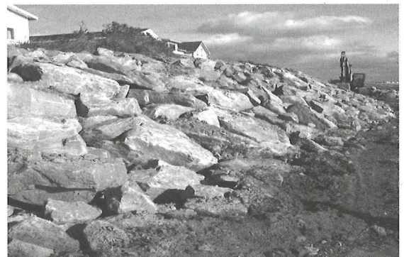
Protection d'un terrain privé à Havre-Aubert - Source : municipalité des Îles - Automne 2007
